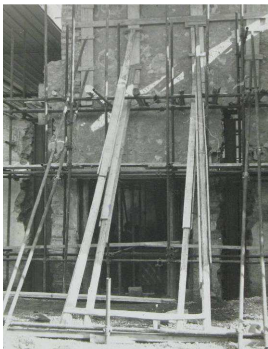
Figg. 3-4 L'inserimento di putrelle verticali in ferro per rinforzare la struttura ai lati del portale d'ingresso alla villa (arch. foto SANP - D-61560 e D-61563 del 20-11-80).
