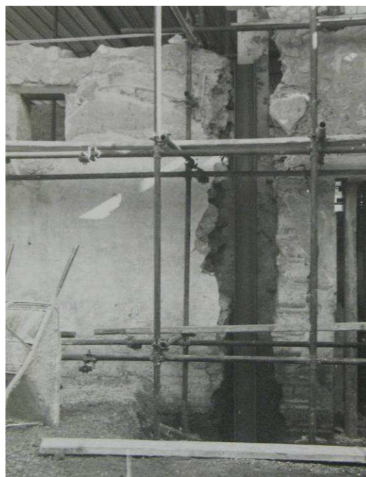
Figg. 3-4 L'inserimento di putrelle verticali in ferro per rinforzare la struttura ai lati del portale d'ingresso alla villa (arch. foto SANP - D-61560 e D-61563 del 20-11-80).
