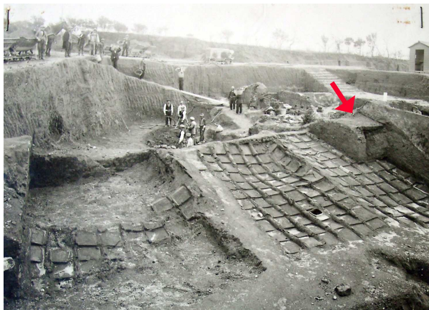
Fig. 35 Il tetto della Casa del telaio e di parte della Casa sannitica di Ercolano rinvenuti in posizione al momento dello scavo. Si noti sulla destra l'abbaino che copriva la scala che saliva al primo piano della Casa sannitica (arch. foto SANP - E2508).
