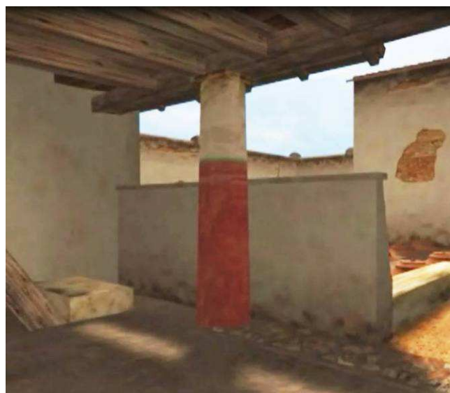
Fig. 30 La situazione di appoggio anomalo della travatura di sostegno del terrazzino dal lato del colonnato appare evidente già in questa ricostruzione dell'Ing. Capasso di Capware dove le travi vanno semplicemente ad appoggiarsi all'architrave sopra le colonne creando una situazione staticamente instabile.
