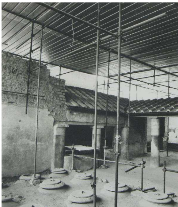
Fig. 5 L'immagine mostra chiaramente come nel 1988 soltanto la copertura del portico era stata realizzata. La restante parte della villa continuava ad essere protetta dalla copertura provvisoria di cantiere (arch. foto SANP - D-55827 del 25-6-88).
