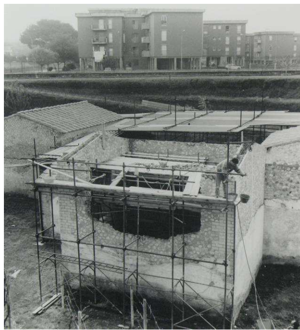
Fig. 6 L'immagine mostra le fasi di lavorazione per la costruzione del tetto del calcatorium del torcularium. Si noti come rispetto all'immagine nel frattempo sono state costruite anche le altre coperture dell'edificio (arch. foto SANP - D-110292 del 1996).
